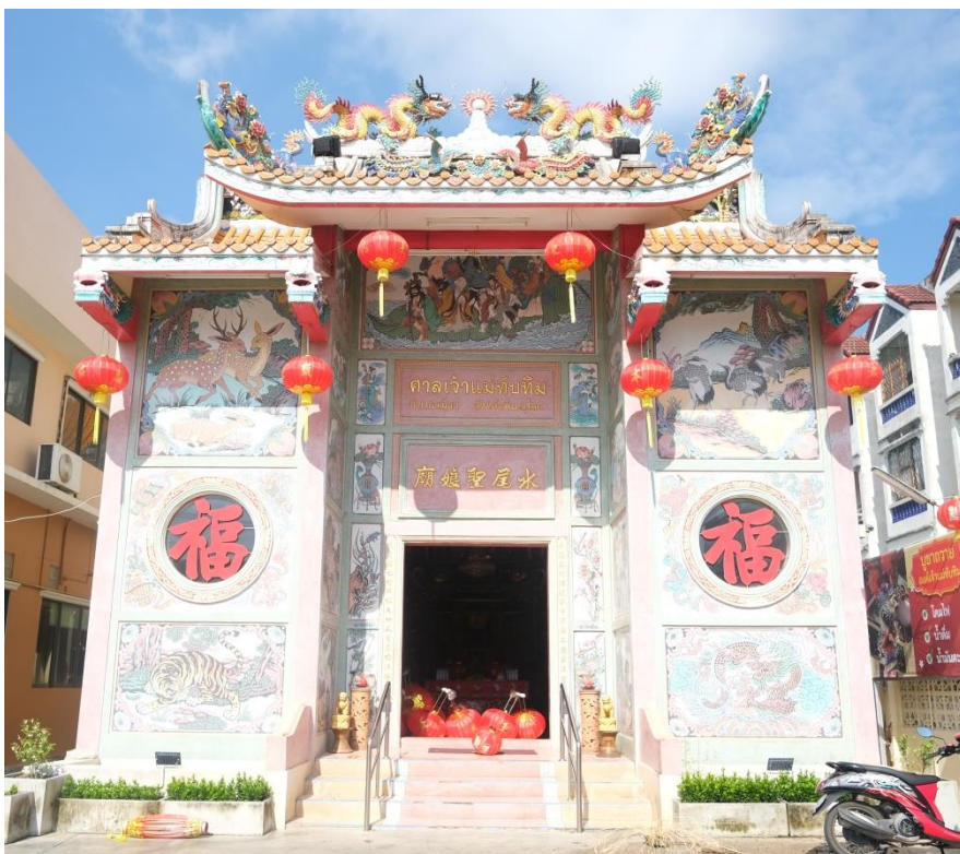
รูปที่ ๒๘๒ ภาพศาลเจ้าแม่ทับทิมหลังจากการรื้อและสร้างใหม่ ณ ที่เดิม
